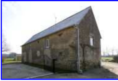
Fig. 4 Etable-grange, vue de trois- quarts arrière vers le sud-est.
