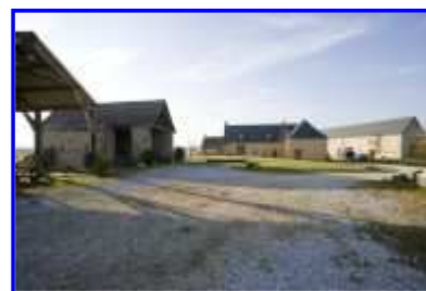
Vue d'ensemble vers l'ouest.
