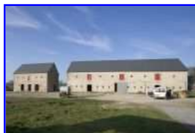
Fig. 8 Les étables-granges : vue vers le nord.
