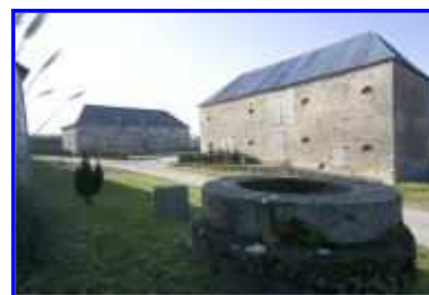
Vue partielle vers le sud-ouest.
