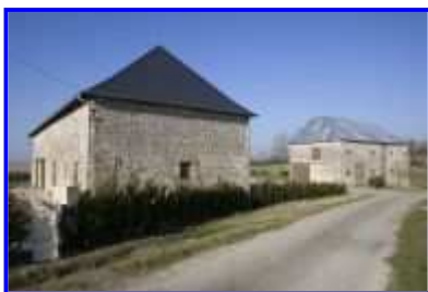
Fig. 4 Vue partielle vers le nord-ouest.
