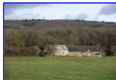
Vue de situation vers le nord-ouest.
