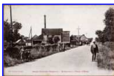
Fig. 8 Vue d'ensemble vers le nord-ouest.
