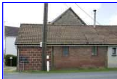
Fig. 14 Extension de l'atelier-halle situé en bordure de la route départementale.
