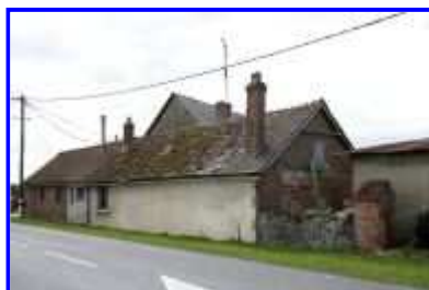
Fig. 13 Atelier-halle situé en bordure de la route départementale, vue vers le sud.
