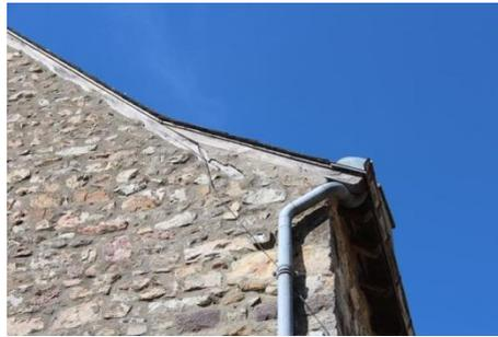
Détail de toiture : le coyau permet de diminuer la pente du toit au niveau de l'égout, et ainsi de mieux évacuer les eaux de pluie et de protéger la charpente et les murs de l'humidité.
